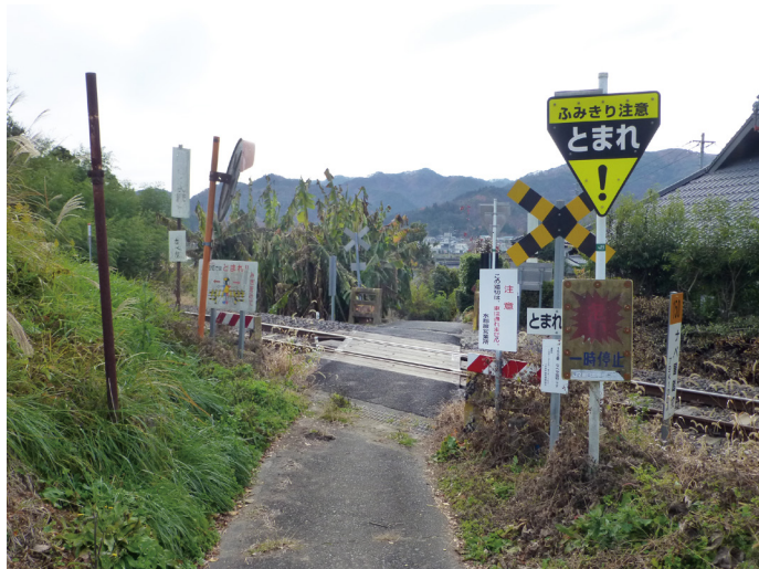
警報機、遮断器ともない第4種踏切の例—水郡線ナベ屋踏切(磐城石井～磐城塙)
