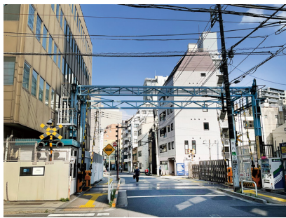
踏切全景、左が「上野検車区」の建物
